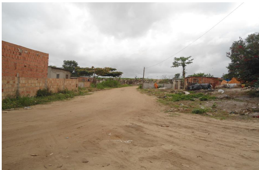
Foto 1. Bairro Liberdade – Inadequação de Domicílios; Casas próximas ao lixo.
